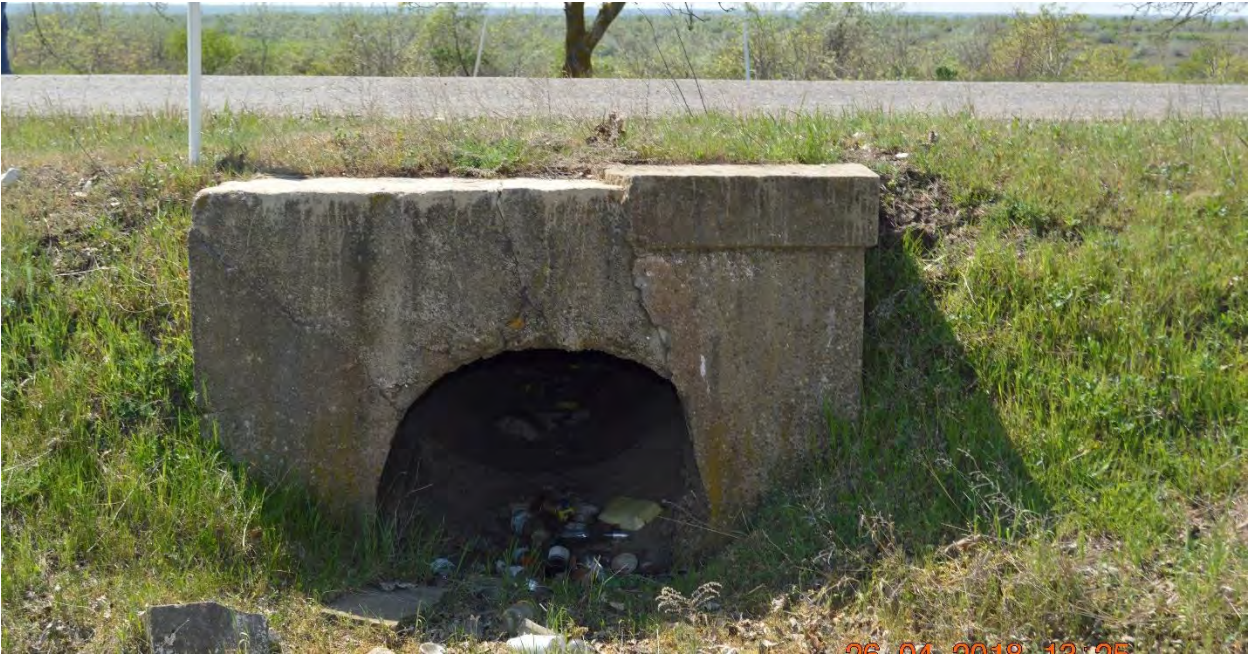
Km 29,480. Vedere în aval.
