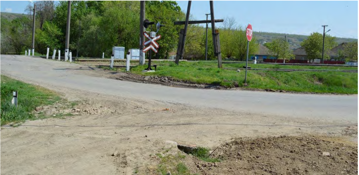
Km 21,980. Intersecție cu calea ferată.
