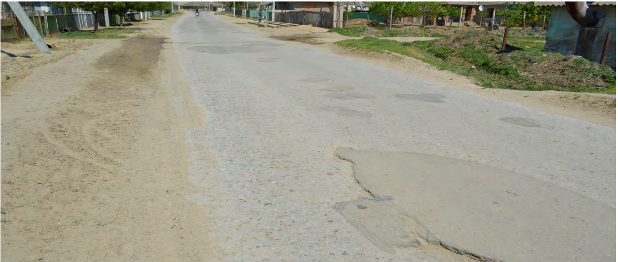
Km 13,600. Valurile de pământ în lungul părții carosabile înrăutățesc condițiile de evacuare a apelor pluviale.
