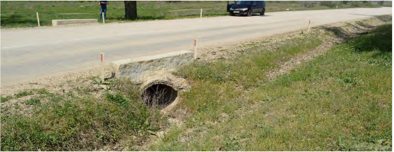
Km 4,300. Podețul sub unghi față de axa drumului.
