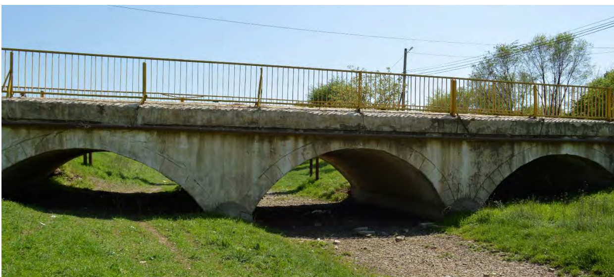
Km 26,160. Pod cu arce cu trei deschideri. Vedere în aval.
