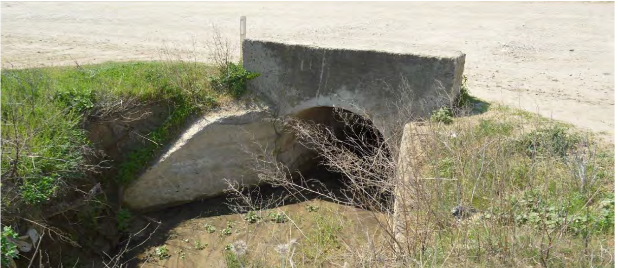
Km 12,900. Vedere în aval.
