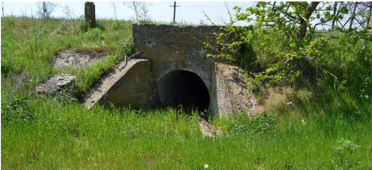
Km 18,200. Vedere în amonte.
