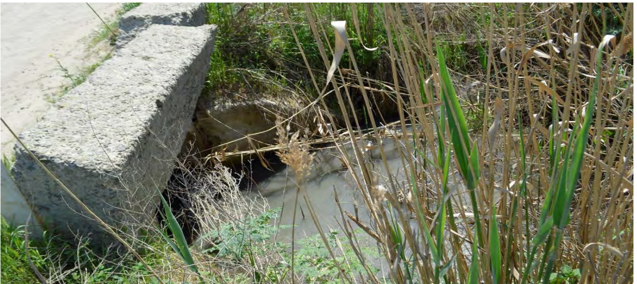
Km 12,900. Staționarea apei la intrare în poduț.
