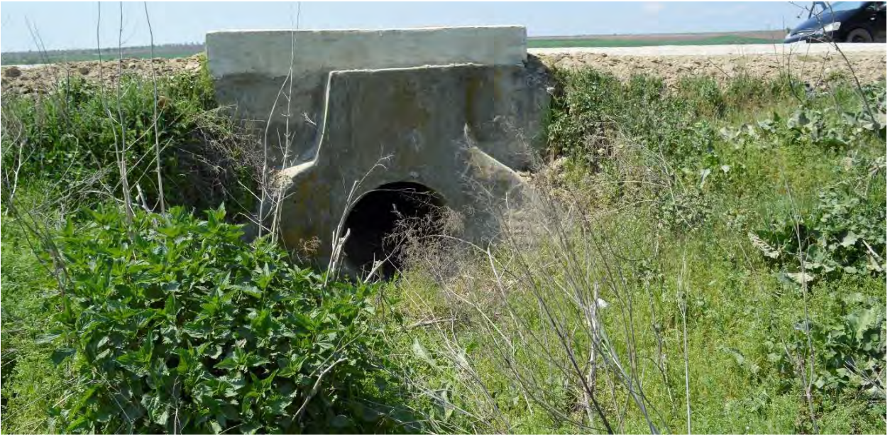
Km 12,700. Vedere în aval.
