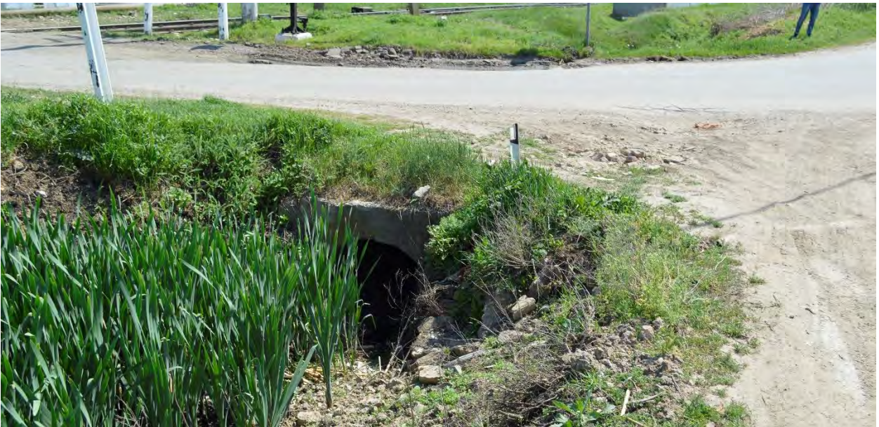
Km 21,980. Vedere în amonte.
