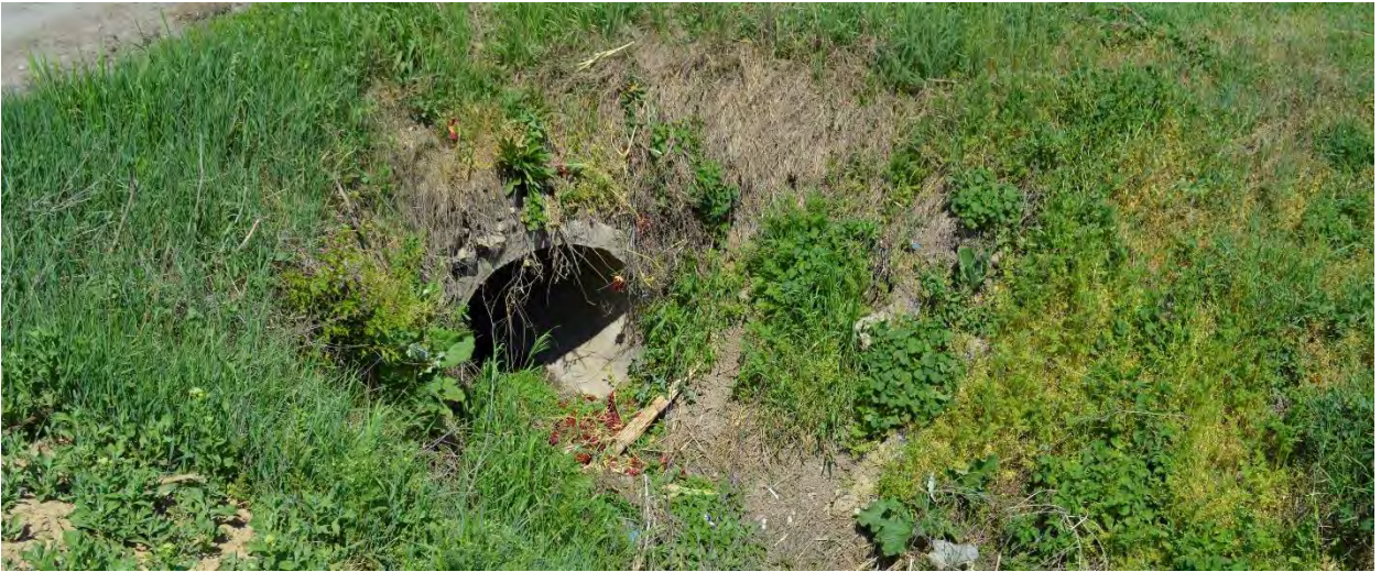
Km 21,980. Vedere în aval.
