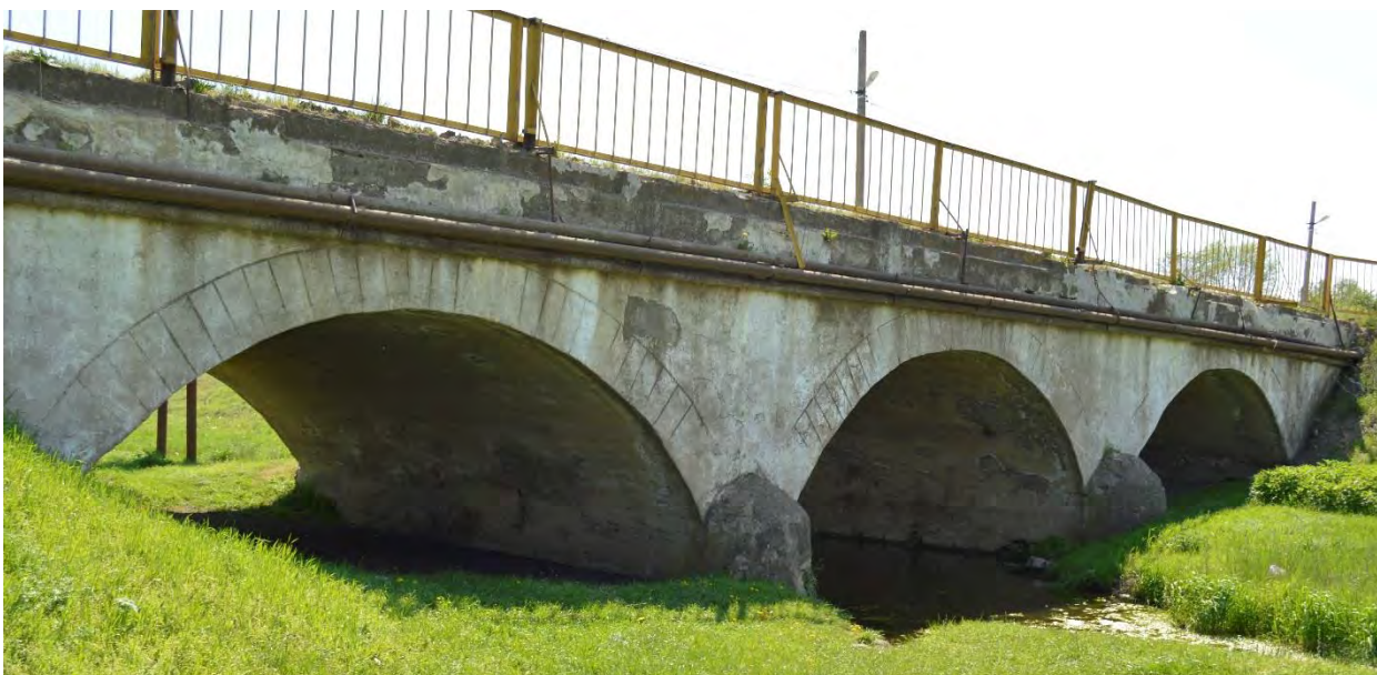
Km 26,080. Pod cu arce cu trei deschideri. Vedere în amonte.
