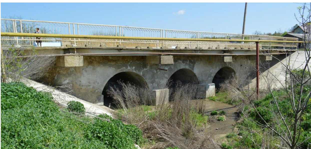
Km 6,200. Pod cu trei arce. În 2016 s-au efectuat lucrări de consolidare. Vederi în amonte și aval.
