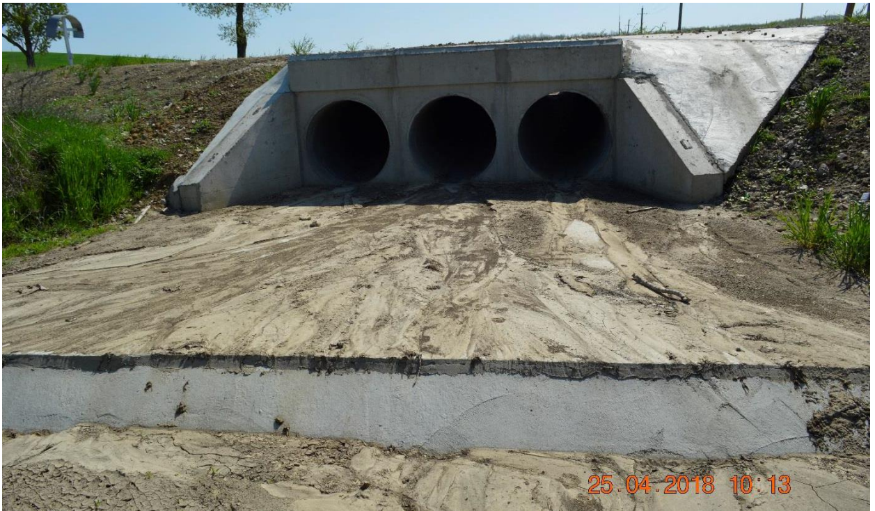
Km 1,200. Podețul tubular cu trei deschideri în stare bună.
