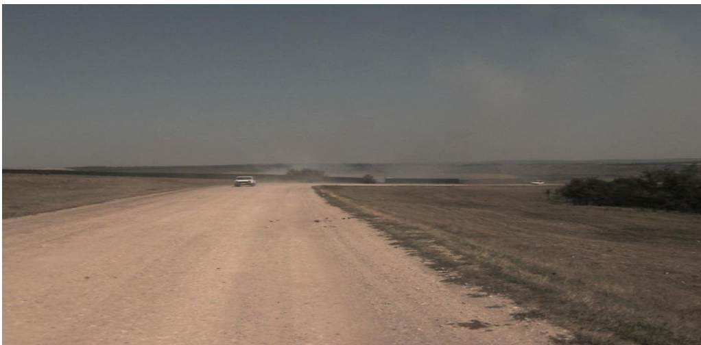
Figura 5.1.1. Pe drumurile din pietriș se formează nori de praf.
