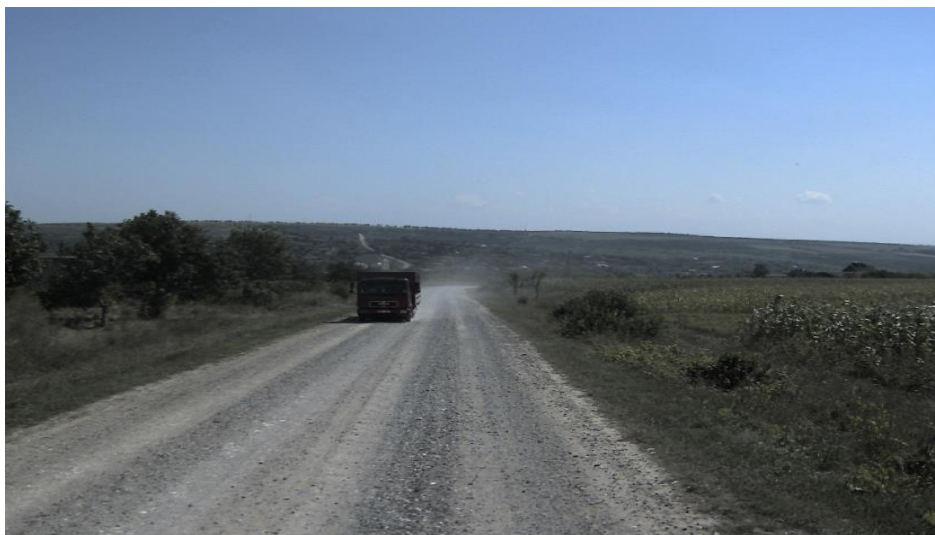
Figura 3.9.1 Pe drumurile din pietriș se formează nori de praf.
