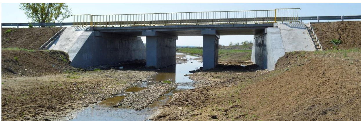
Pod la km 0,500. Vedere în amonte. Stare bună.
